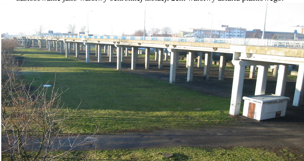
Rys. 1. Widok ogólny obiektu w kierunku Wschowy - estakada główna południowa.
