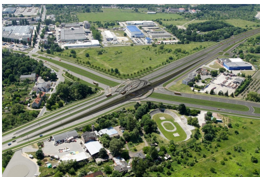
Rys. 6. Obwodnica Śródmiejska – widok węzła z ul. Żmigrodzką.
