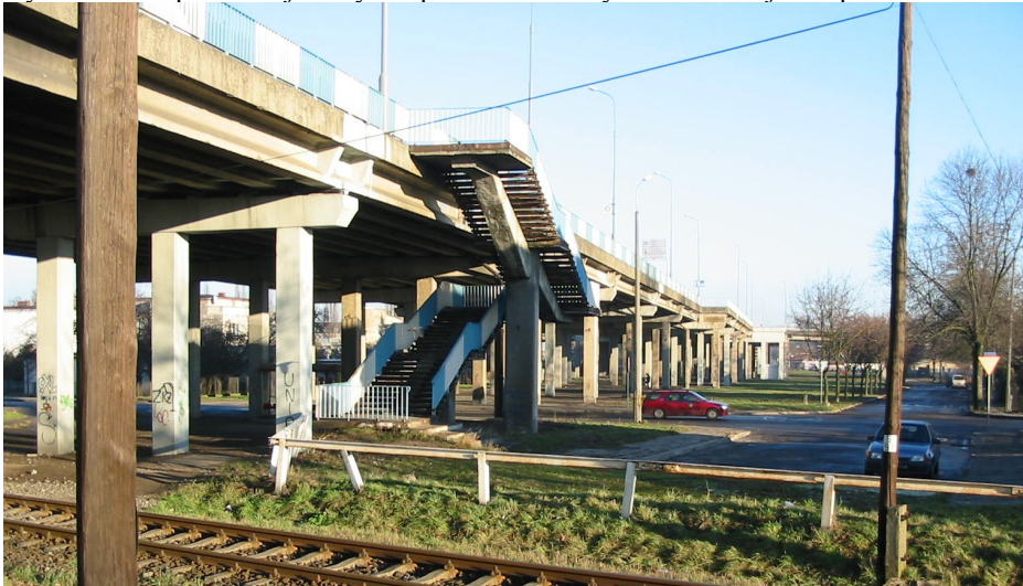
Rys. 2. Widok ogólny obiektu w kierunku Leszna - estakada główna południowa.
